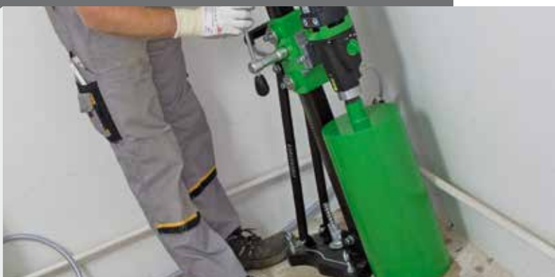
BST 182 V / S: carruagem montada em 4 bolas especiais
