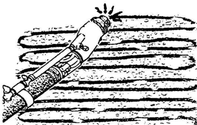
Figura 30: Desloque o aparelho de projeção em movimentos suaves de vaivém
