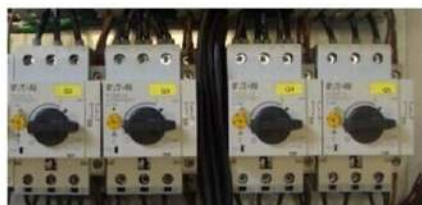
Figura 4: Interruptor de proteção do motor 400V
