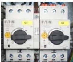
Figura 5: Interruptor de proteção do motor 230V
