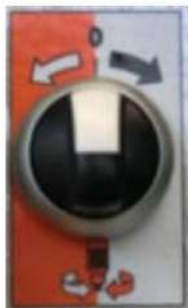
Figura 24: Seletor para motor de bomba de 230V
